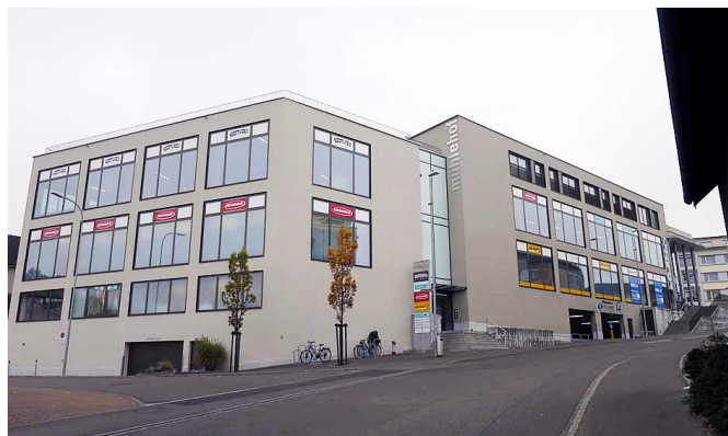
Zeitpunkt: Jan. 2016 | Adresse: Bahnhofstrasse 82, Uzwil | Verkehrswert 31.12.2016: CHF 15.42 Mio. | Bruttorendite: 5.60%
