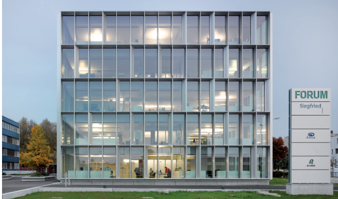
Zofingen, Untere Brühlstrasse 4
